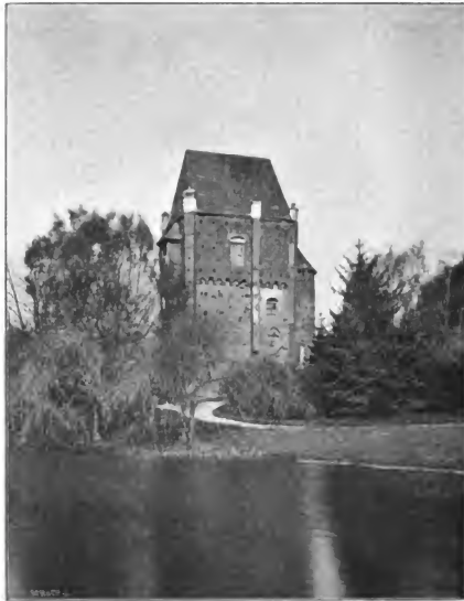
Abb. 47. Schloß-turm in Samter. Südostseite.
