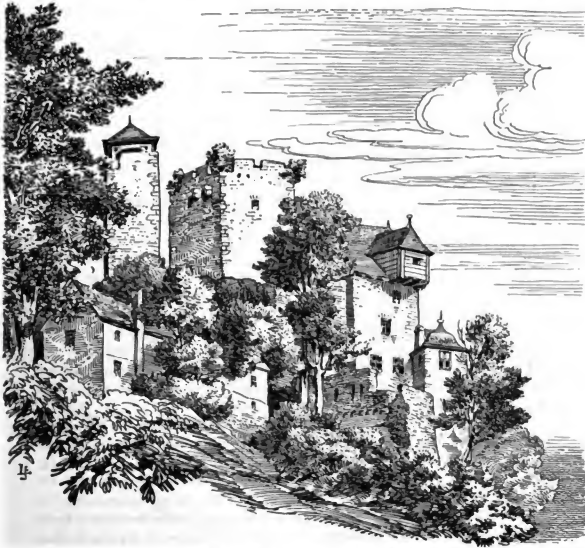
Fig. 229. Burg Hohlenfels. Ansicht von Südosten.
