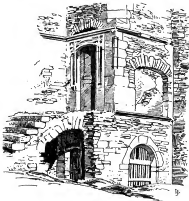
Fig. 40. Schloss Löhnberg. Treppenturm.
