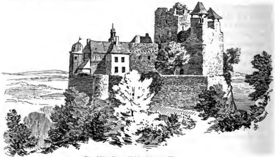
Fig. 228. Burg Hohlenfels von Westen.
