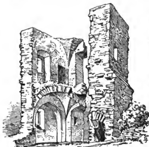
Fig. 239. Burg Langenau. Nördlicher Mauerturm.
