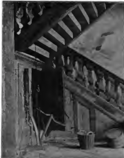
Fig. 242. Burg Langenau. Treppenhaus im MariotNischen Bau.
