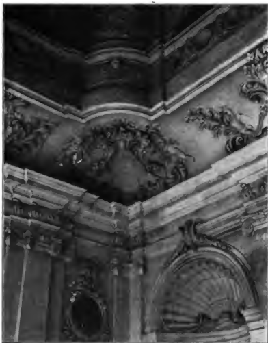
Fig. 15. Weilburg. Mittelsaal der Orangerie.
