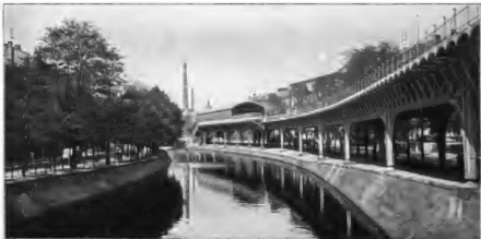
1. Hochbahnstrecke am Halleschen Ufer mit der Haltestelle Möckernbrücke.
