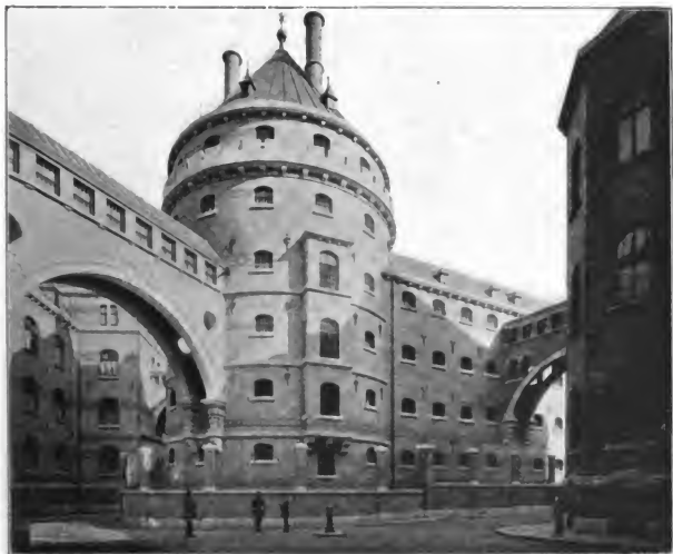
Fig. 252. Gerichtsgebäude. Hofansicht mit dem Untersuchungsgefängnis.
