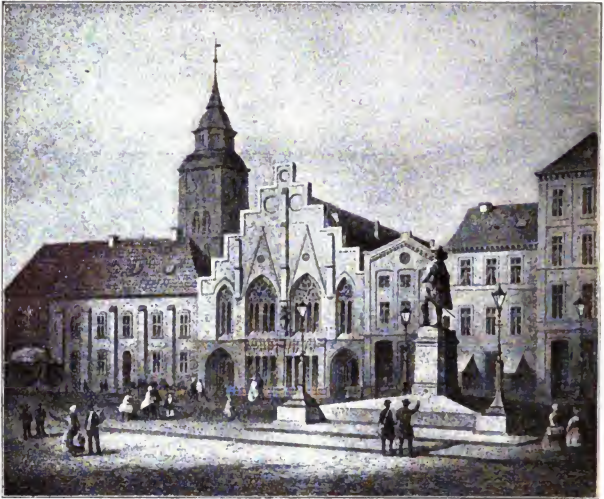
Fig. 291. Alte Ansicht des Domanbaus, nach einem Stahlstich um 1850.
