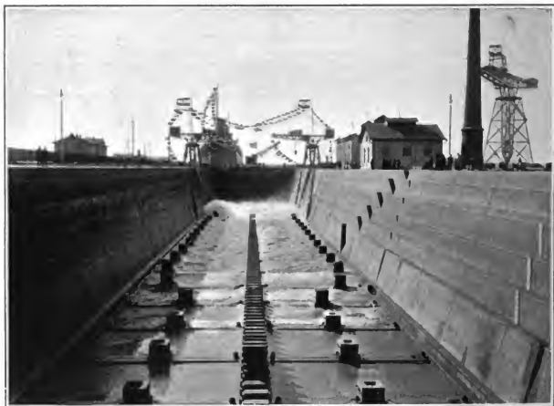
Fig. 575 Kaiserdock. Beginn der Füllung.
