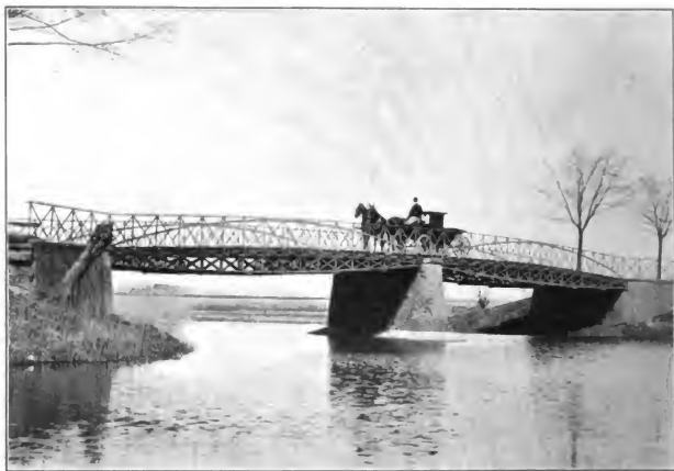
Fig. 495. Flutbrücke bei Warturm.
