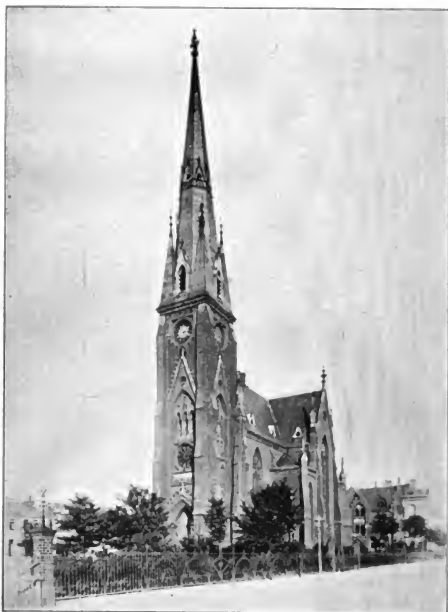
Fig. 229. Äußere Ansicht der Wilhadikirche an der Nordstraße. J. Rippe. 1878.
