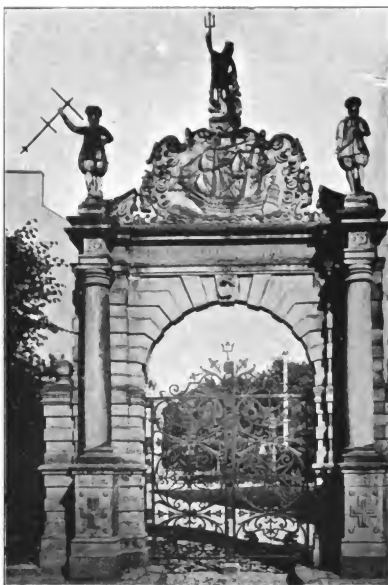
Fig. 24. Portal des Hauses Seefahrt.
