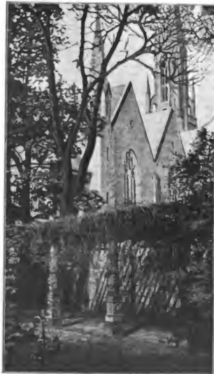
Fig. 228. Äußere Ansicht aus dem Hofe von Heinrich Müllers Wohnhaus.
