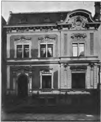
Fig. 528. Wohnhaus Banck, Kohlhückerstraße 20. A. Dunkel. 1894.
