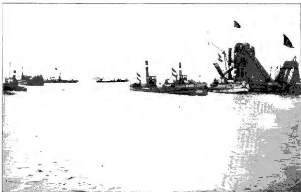
Fig. 548. Bagger B II im Betrieb, Dampfprahme.
