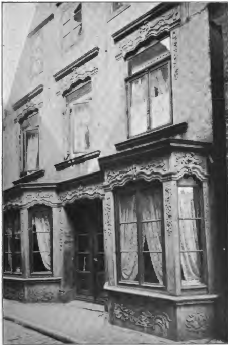
Fig. 199. Haus an der Balgebrückstraße, jetzt abgebrochen.
