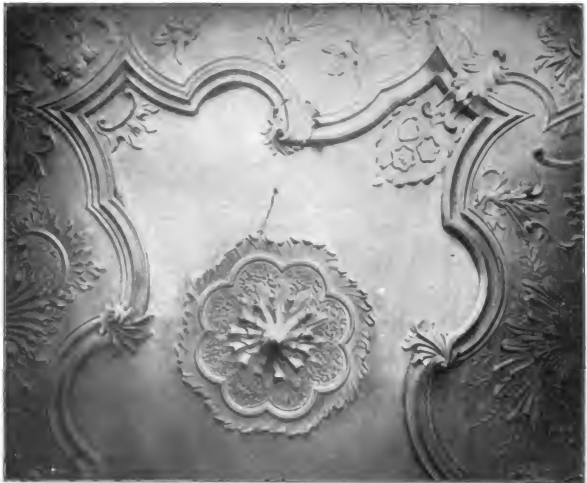
Fig. 203. Stuckdecke aus dem abgebrochenen Hause Martinistraße Nr. 11.
