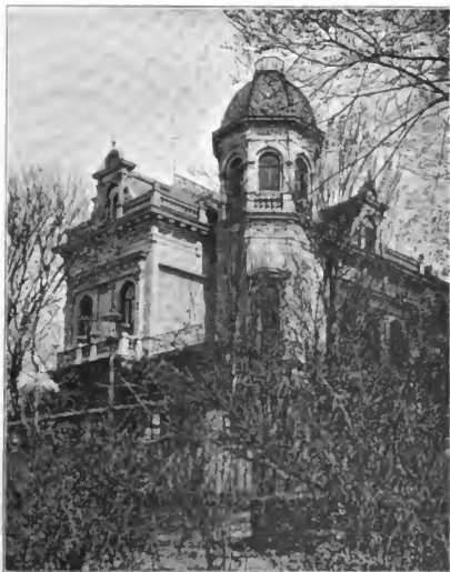
Wohnhaus des Architekten J. Poppe, an der Contrescarpe.
