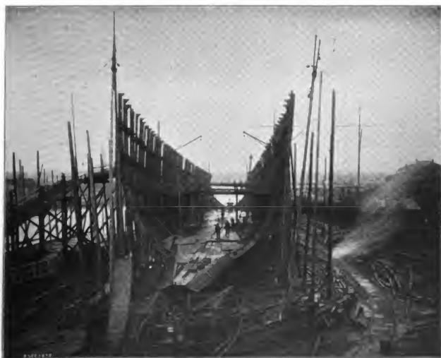
Fig. 512. Lloyddampfer „Köln“ in Spanten. (Tecklenborgs Werft.)
