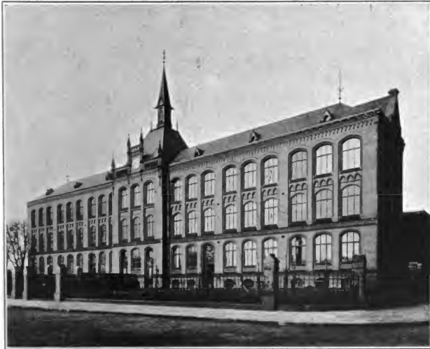
Fig. 245. Ansicht der Volksschule an der kleinen Allee und des Technikums.
