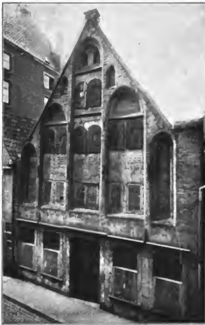
Fig. 156. Gotisches Giebelhaus Großenstraße Nr. 45.
