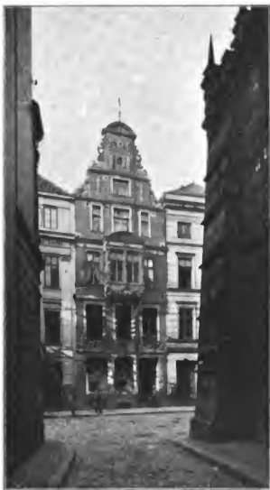
Fig 182. Giebelhaus an der Langestraße Nr. 137, gegenüber der Waage.
