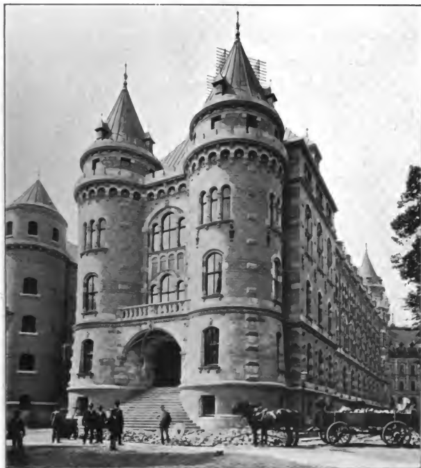
Fig. 254. Gerichtshaus. Rückseite an der Sandstraße.
