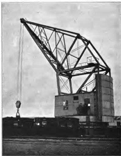
Fig. 572. 30-t-Druckwasserkrahn.
