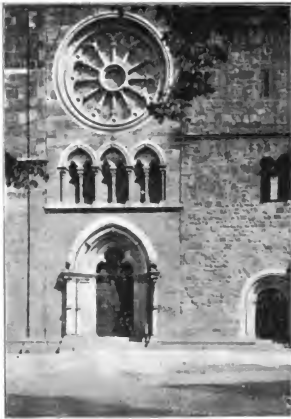
Fig. 67. Mittelbau der Westfront der Liebfrauenkirche nach der Restauration.
