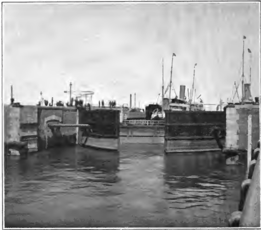
Fig. 566. Aufsicht der großen Kaiserschleuse mit Stemthoren.
