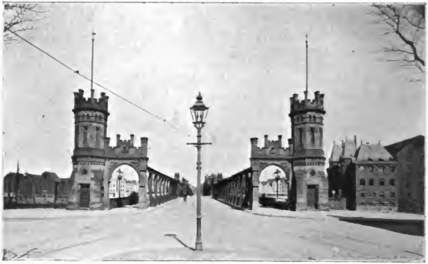
Fig. 441. Portal der Kaiserbrücke.
