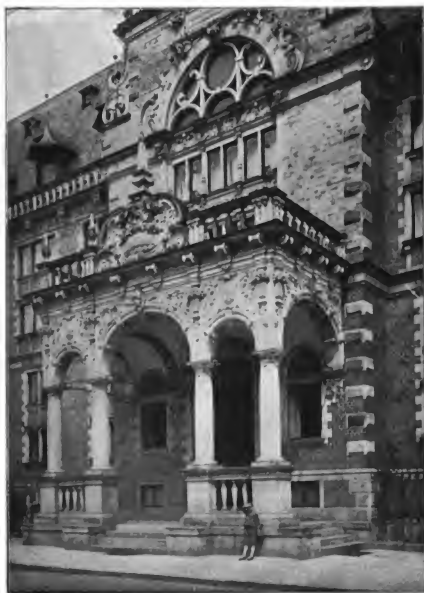
Fig. 290. Mittelbau der Stadtbibliothek mit der Vorhalle.
