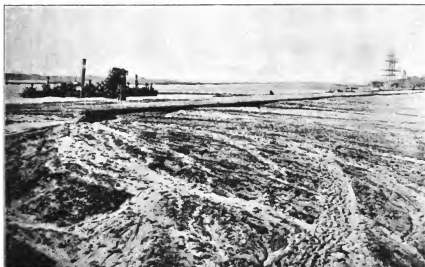
Fig. 547. Einerbagger und Schwemmapparat im Betrieb.
