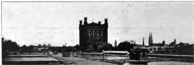
Fig. 422. Gesamtansicht des Wasserwerks.
