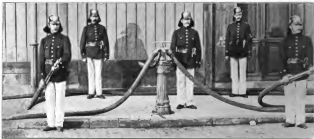
Fig. 451. Überflurhydrant.
