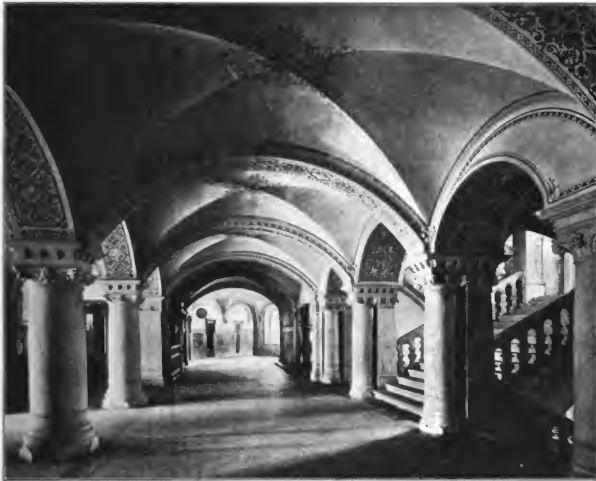
Fig. 258. Gerichtshaus. Korridor im Erdgeschofs und Treppenhaus.
