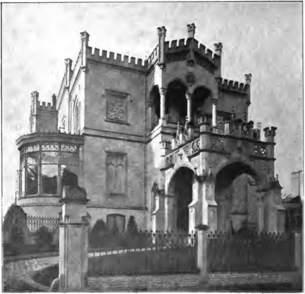
Fig. 442. Fassade Bleicherstraße, nach dem Umbau durch Alb. Dunkel.
