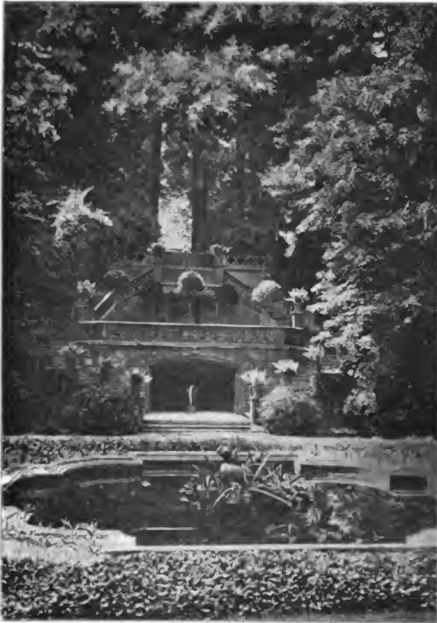
Fig. 462. Freitreppe im Park des Schlosses v. Knoop, St. Magnus. Architekt Runge. 1868.
