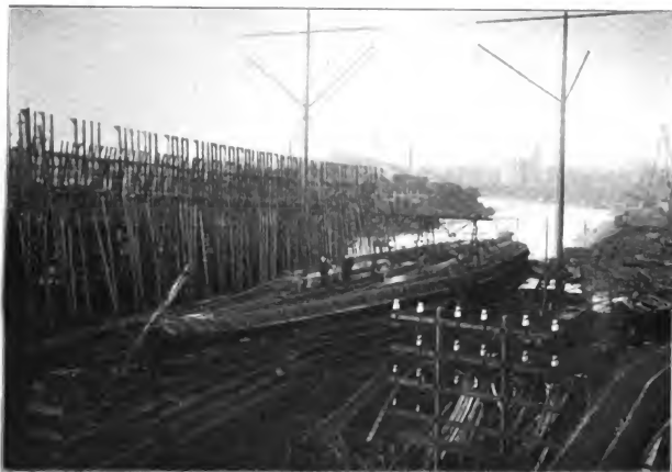
Fig. 511. Lloyddampfer „Frankfurt“. Ansicht des Doppelbodens. (Tecklenborgs Werft.)
