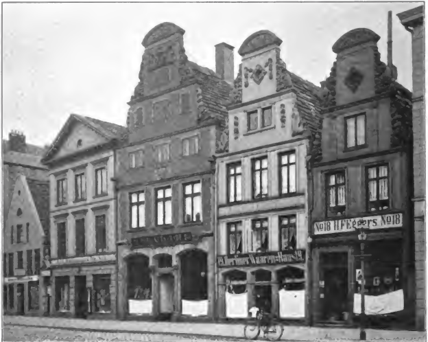
Fig. 181. Giebelhäuser an der Brautstraße Nr. 18, 19 u. 20.
