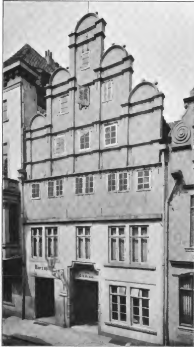
Fig. 158. Giebelhaus Wachstraße Nr. 33.
