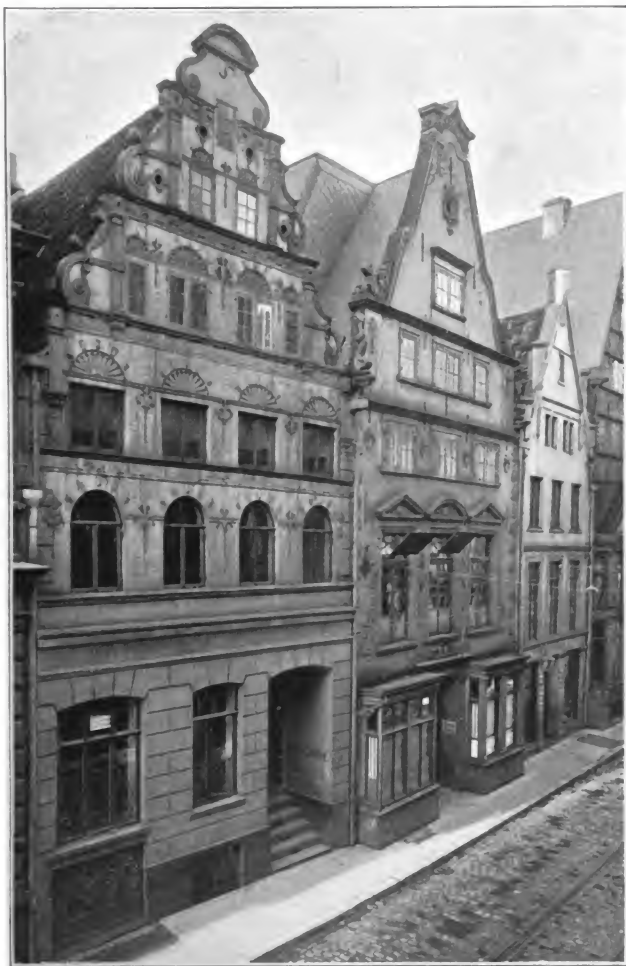
Fig. 169. Haus an der Langenstraße Nr. 124.
