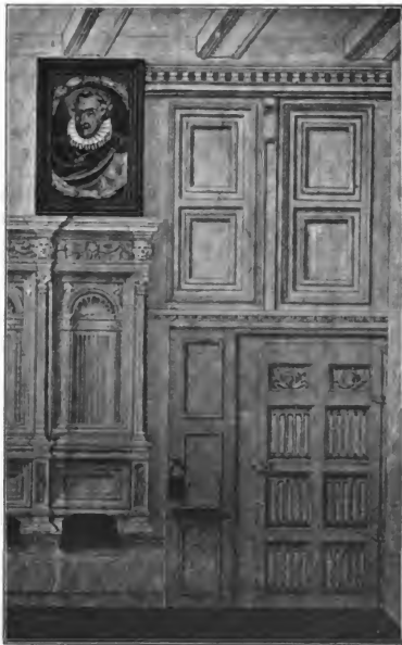
Fig. 124. Ehemalige Vertäfelung der Obergerichtsstube. Nach alter kolorierter Aufnahme im Archiv.
