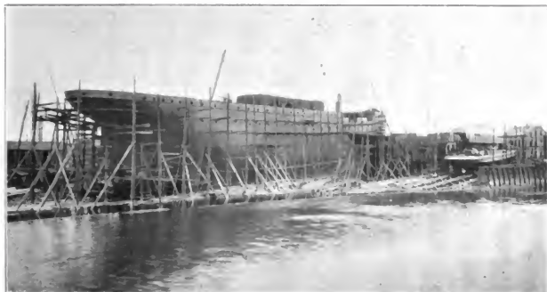
Fig. 514. Lloyd dampfer „Mainz“ auf dem Helgen, beplattet. (Tecklenborgs Werft.)
