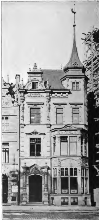
Fig. 391. Ansicht der Neuen Sparkasse am Markt. Architekt Alb. Dunkel. 1895.
