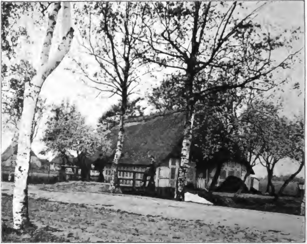
Fig. 345. Altes Ansiedlerhaus im Teufelsmoor bei Bremen.
