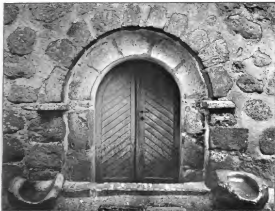
Portal auf der Nordseite der Kirche.
