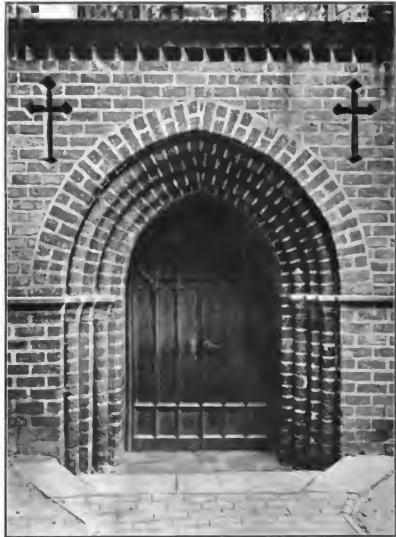
Portal auf der Nordseite.
