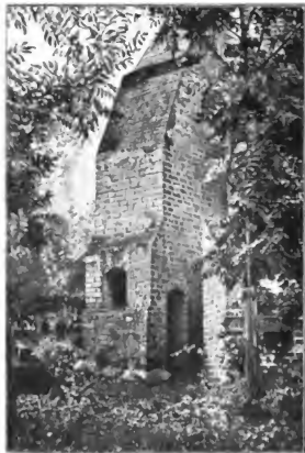
Strebpfeiler an der Südostecke der Kirche.
