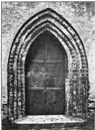
Portal auf der Südseite der Kirche.
