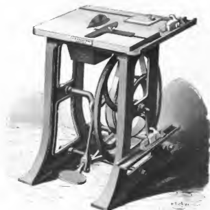
Fig. 21. Kreissäge mit Bestanzzeug von A. Hogenfort in Leipzig.
