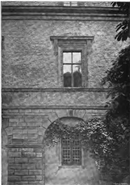
Obr. 114. Nelahorzeves. Okno ve východním traktu zámku; sazební chodba v příměří.
