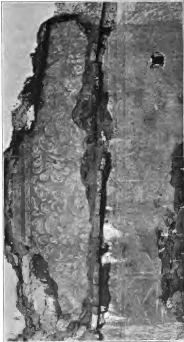
Obr. 4. Bakov. Sgraffita na straně severní.
