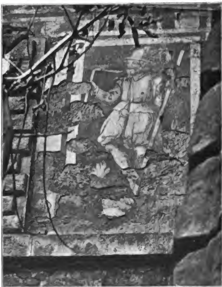
Obr. 306. Nelahoseves. Domnělá postava stavitele zámku.
