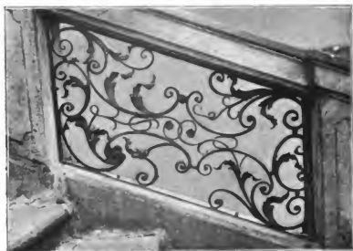
Obr. 213. Smečno. Mříž v zátku na schodišti do parku.
