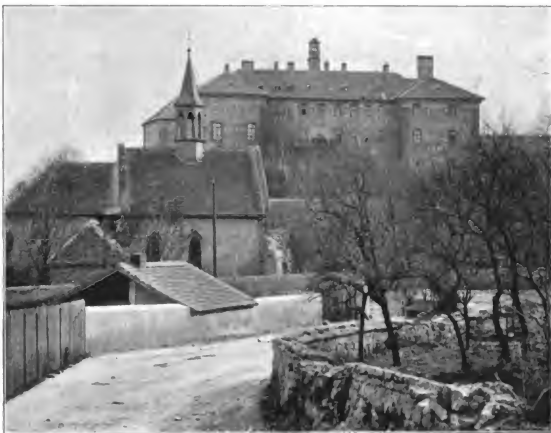
Obr. 107. Nelahozeves. Zámek a kostel.
