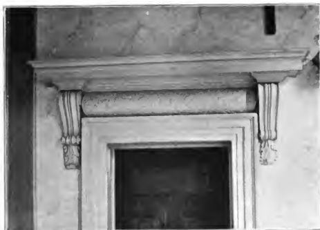
Obr. 113. Nelaboseves. Ostění dveří v sámku.
