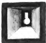
Obr. 144. Okno (střílna) ve zvonici.
