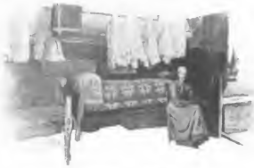
Inneres eines Hochhauses.
