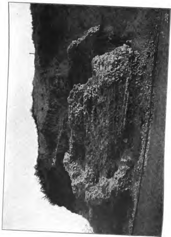
Römische Mauer beim Citadellenthore in Metz. Mauerfüllung. Die zweite Mauer ist mittelalterlich.
