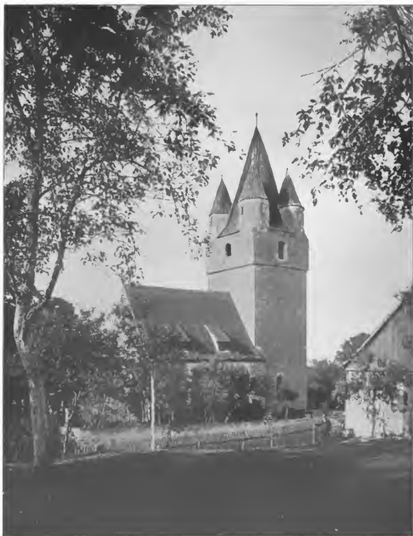
Ansicht der Kirche in Oberoppurg.
