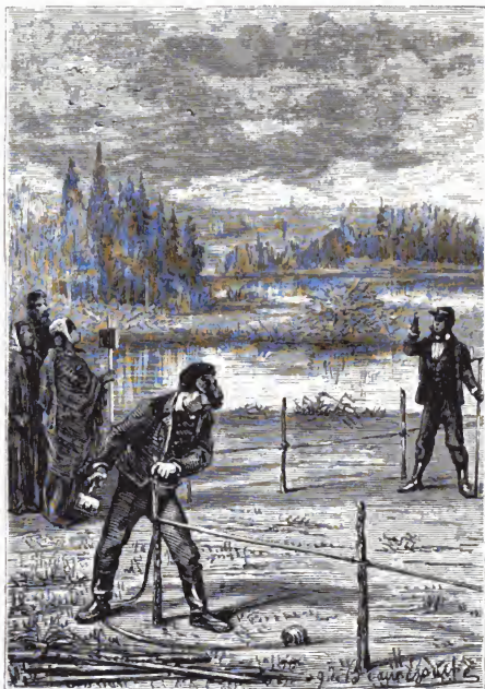
Absteckung des zukünftigen Wohnhauses. (S. 119.)
