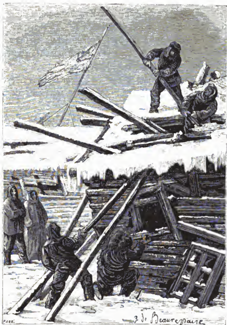
Das Wohnhaus nach dem Erdbeben. (S. 218.)
