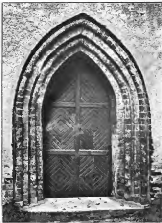
Portal auf der Südseite der Kirche.
