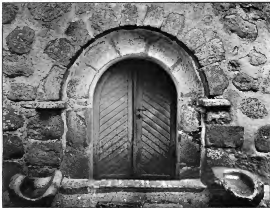
Portal auf der Nordseite der Kirche.
