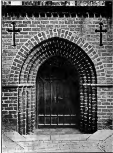
Portal auf der Nordseite.
