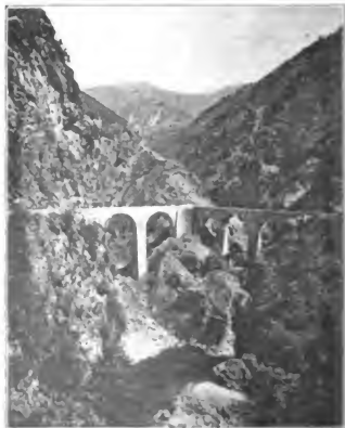
Der Ponte Oscuro im Val Onsernone.
