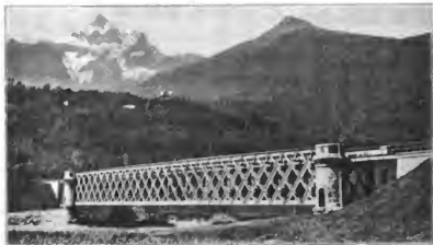
Eisenbahnbrücke bei Massongex.
