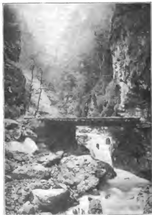
Brücke über die Melchaa.
