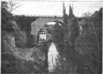
Brücke über die Orbe bei der Stadt Orbe.
