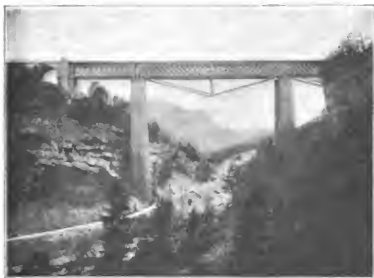
Brücke der Linie Lausanne-Pontarlier bei Vallorbe.
