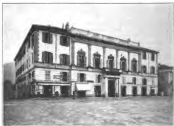
Locarno: Ehemaliges Regierungsgebäude.
