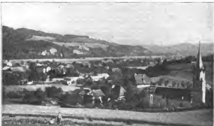
Oberburg von Nordwesten.
