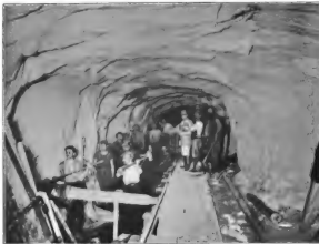
Erweiterungsarbeiten im Tunnel.
