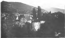
Aus dem Stadtteil Landshühldörfer: Ruinen der Tiefburg, das Schloßchen und die Kirche.
