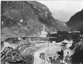
Inhalation für den Tunnelbau bei Njella.
