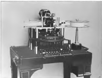
Stanzapparat zur Herstellung des Telegramms in Vochschrit.
