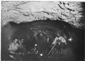
Schütterspeien im Stollen vor Ort.
