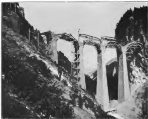
Landwasserviadukt im Bau.
