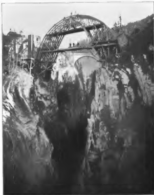
Die Solisbrücke im Bau.
