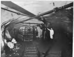
Querriegel und Luftlokomotive im Tunnel.
