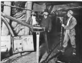
Abfedung der Achse im Tunnel.
