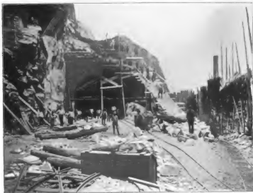
Tunnelbau auf der südlichen Zufahrtslinie. Oberes Portal des großen Splartunnels.
