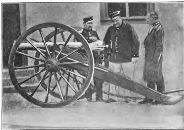
Jäger Major, Bauhaus-Werkmeister Gezogener 6 Äer mit Keilverschluß und Blockafette.
