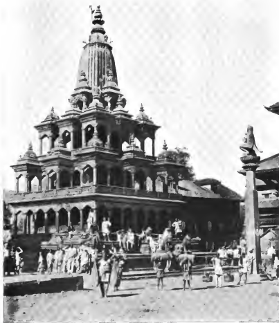
Säule mit Garuda-figur vor dem brahminischen Dschain-Tempel in Patan.
