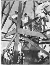
Der unterste Ring des Thi wird auf der Pagodenspitze befestigt.
