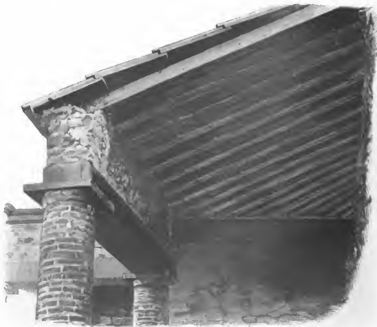
Fig. 140. Dach im Peristyl der domus C. Vibii .
