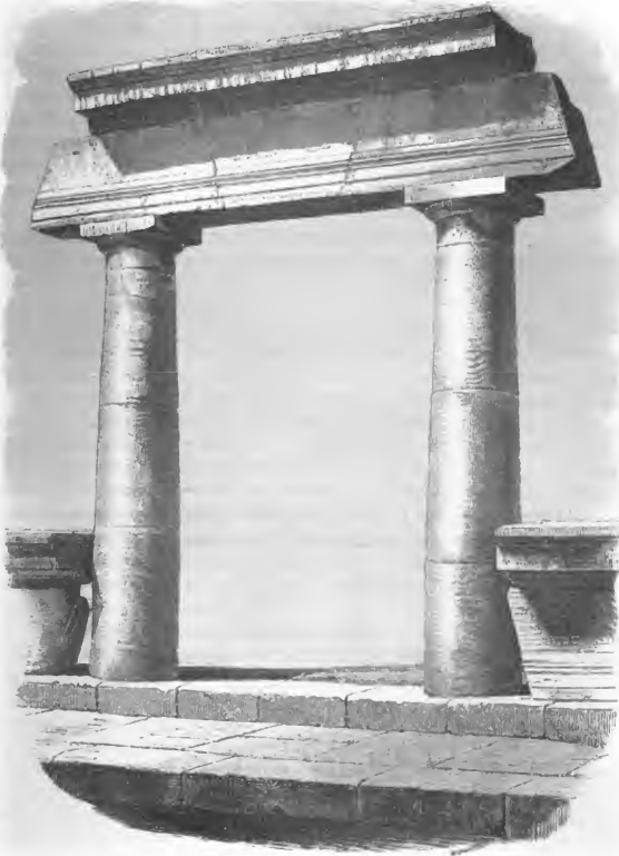
Fig. 269. Probestück der restaurirten Forumcolonnade von der Westseite.
