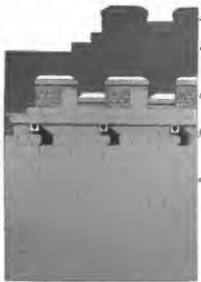
Fig. 10. Ansicht der Mauer.
