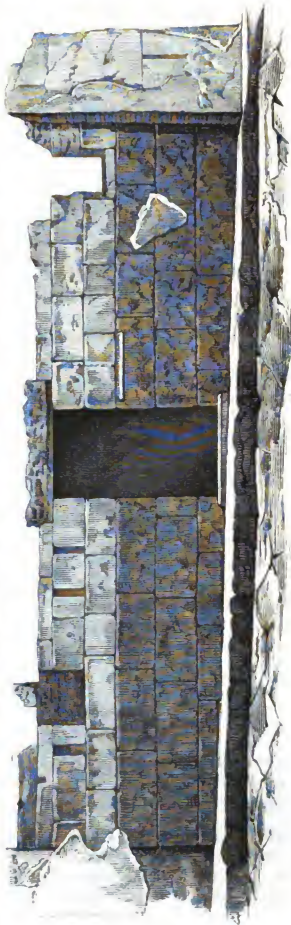
Fig. 263. Probe des Gesteins und der Bauweise der ersten und zweiten Periode.
