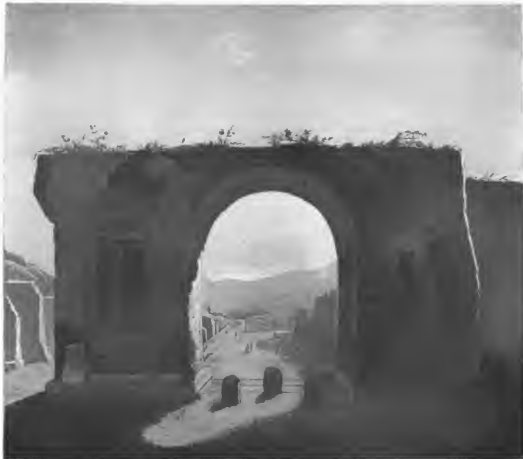
Fig. 26. Äußere Ansicht des s. g. Triumphbogens.
