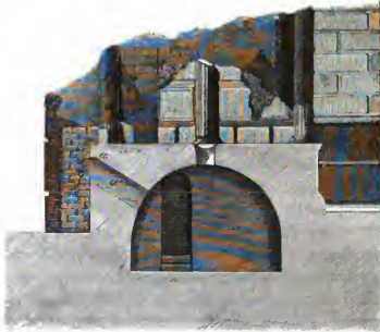
Fig. 80. Raum unter der Tribüne.
