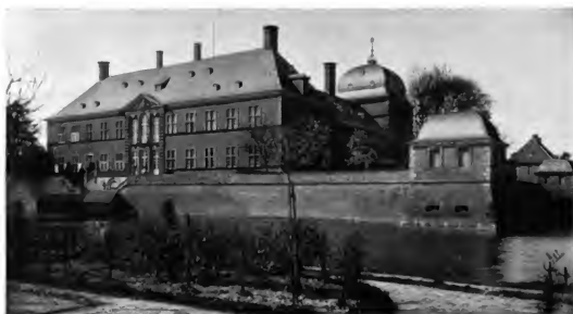
210. Schloß Ahaus. — Rückfront Der Mittelrisalit von Johann Conrad Schlaun 1766 eingebaut
