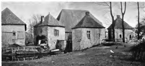
83. Haus Harkotten. — Wachhäuser an der Einfahrt der Burg
