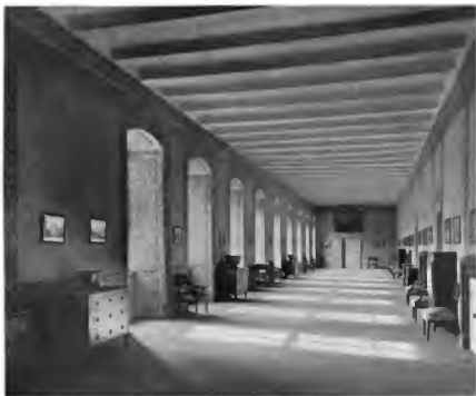
333. Abtei Corvey. — Korridor
