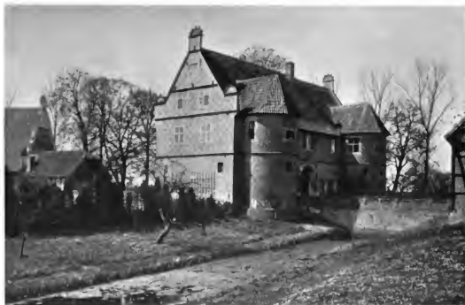
77. Haus Byink. — Torgebäude von 1561; das Herrenhaus (links) von 1558 in der Art der westfälischen Bauernhäuser mit Längsziele und Viehställen
