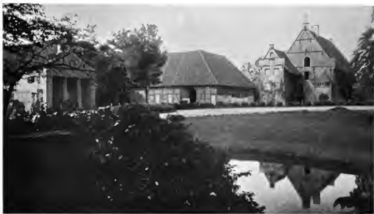
72. Haus Ermelinghof. — Untergebäude
