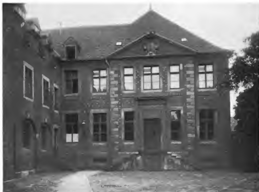
221. Münster. — Generalkommission, Ludgerstraße 13 Im Seitenflügel später neues Obergeschöß
