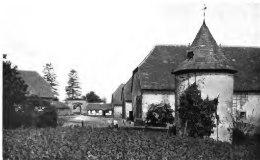
162. Marienmünster. — Ehemalige Benediktinerabtei. Wirtschaftsgebäude und Hoftor
