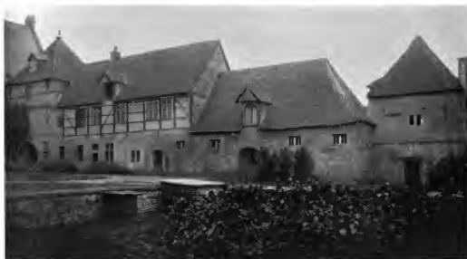
86. Haus Havixbeck. — Untergebäude mit dem gegenüberliegenden einen regelmäßigen, rechteckigen Hof einrahmend, vgl. Abbild. 88
