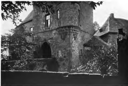
118. Dringenberg. — Fürstlich paderbornisches Jagdschloß Erbaut 1356, umgebaut 1593
