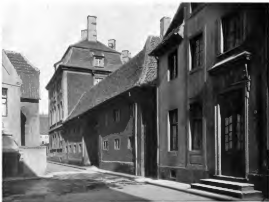
271. Münster. — Partie an der Loerstraße. Seitenansicht des Erbdrostenhofes mit Stallgebäuden
