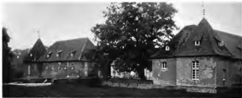
193. Haus Vornholz. — Einfahrt und Untergebäude
