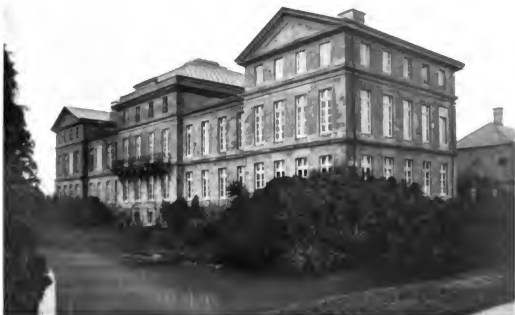
339. Haus Stapel. — Erbaut nach den erhaltenen Plänen von O. Reinking (nach dessen Tode) von 1819–1827
