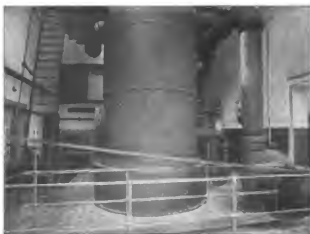
Fig. 39 Kaldampfkondensatoren.
