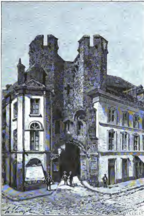
Eingangshalle des früheren Palastes der Grafen von Flandern. (Nach einer Photographie.)
