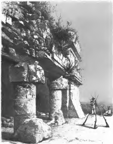
Facade des Castillo.
