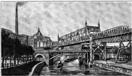
Elektrische Hochbahn in Berlin: Hochbrücke über die Anhalter Eisenbahn.
