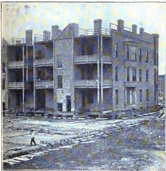
Ein achttausend Tonnen schweres Haus in Chicago wird fortbewegt, um für eine Hochbahn Platz zu schaffen.
