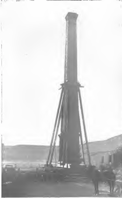
Ein 125 Fuß hoher Schornstein wird in Chelsea (Massachusetts) über eine breite Straße bewegt.
