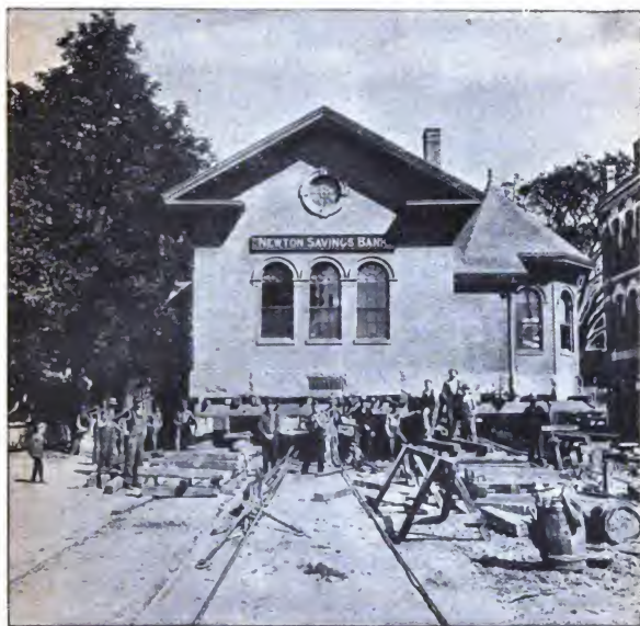
Fortbewegen eines Bankgebäudes zu Newton (Massachusetts) über das Geleise einer elektrischen Bahn.
