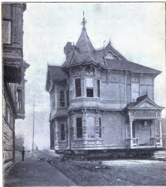
Das Haus wird auf Kollhölzern an seinen Platz gebracht.
