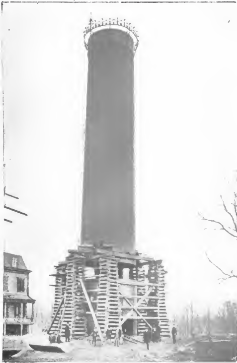
Emporschrauben eines Wasserturmes zu Mount Vernon im Staate New York.
