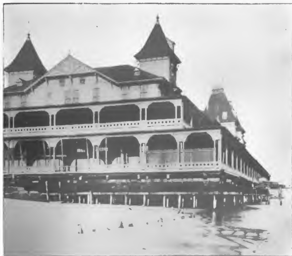
Ein Strandhotel in Brighton wird fortgerückt.
