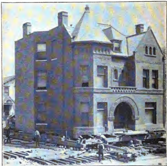
Ein Steinhaus in Chicago wird gedreht.
