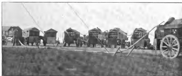
Abbildung 2. — Russische Wagen mit komprimiertem Wasserstoff zur Füllung aufgefahren.
