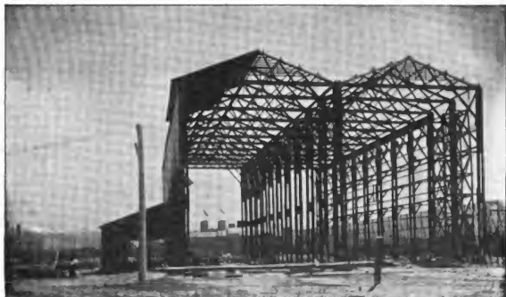
Fig. 1. — „Airshipbuilding“ im Bau.
