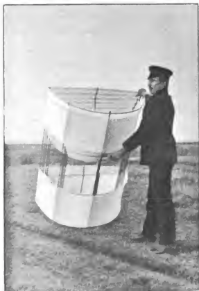
Fig. 2. — Ineinanderschachtelung verschieden großer Drachen zum Transport. (Die Spanndrähte sind dazu auszuhängen.)
