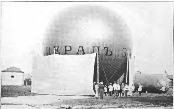
Abbildung 11. — Russische Windwand zum Schutz des Ballons.
