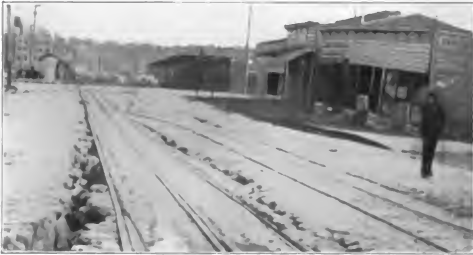
Fig. 11. Risse in Valentia Street, San Francisco, nach dem Erdbeben 1906.
