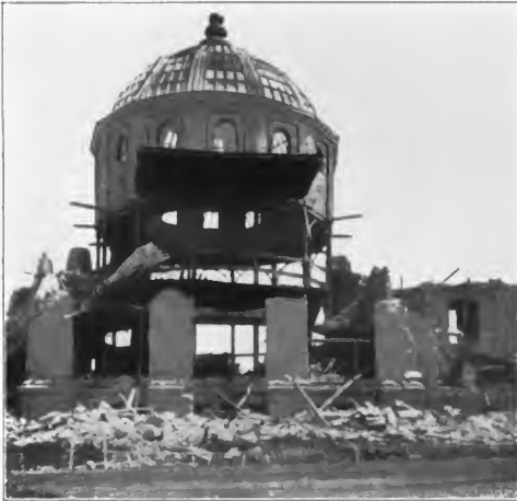
Fig. 14. Das Bibliotheks-Gebäude der Stanford-Universität in Kalifornien nach dem Erdbeben 1906. Das Bild zeigt die große Widerstandskraft der Eisenkonstruktionen, verglichen mit derjenigen von Mauerwerk. Die Einwirkung des Erdbebens auf hölzerne Konstruktionen ist auf Fig. 11 ersichtlich.
