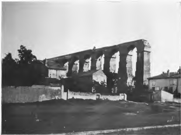
Abb. 44. Römische Wasserleitung bei Metz.
