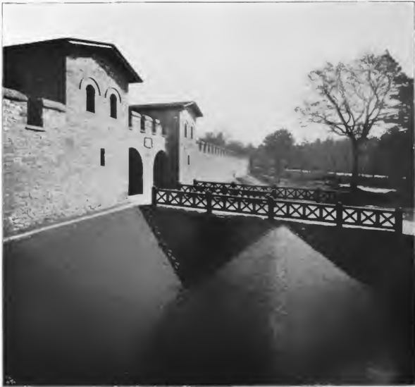
Abb. 56. Zuß wiederaufgebaute Saalburg-Kastell. Porta Tecumana.
