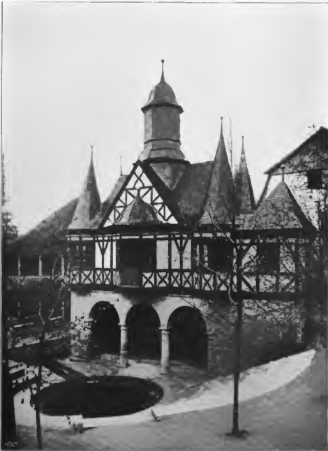
Abb. 160. Quelle nebst Festgebäude zu Popperode bei Mühlhausen in Th.
