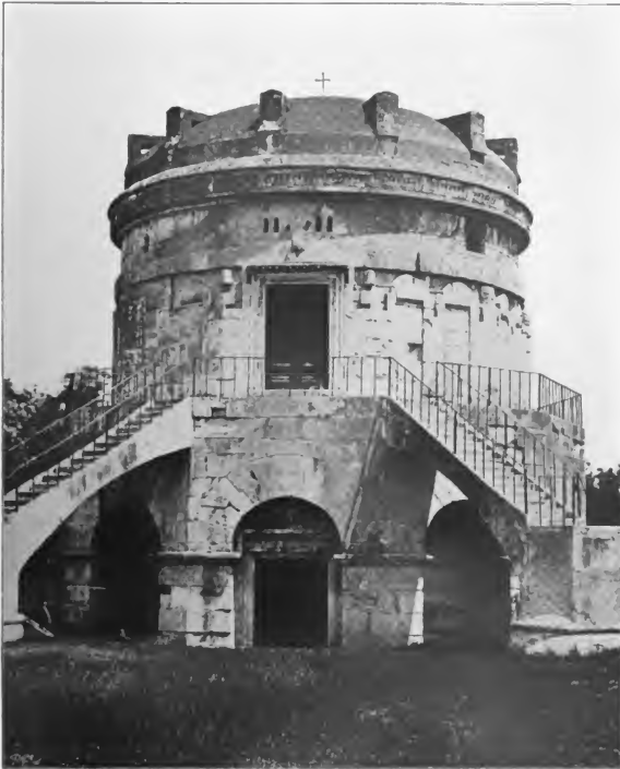
Abb. 60. Grabmal Theoderichs des Großen zu Ravenna in seiner jetzigen Erscheinung. Das Erdgeschoh erhob sich früher weit mehr aus dem selbtem erhöhten Boden; die Aufgänge sind neueren Ursprungs.
