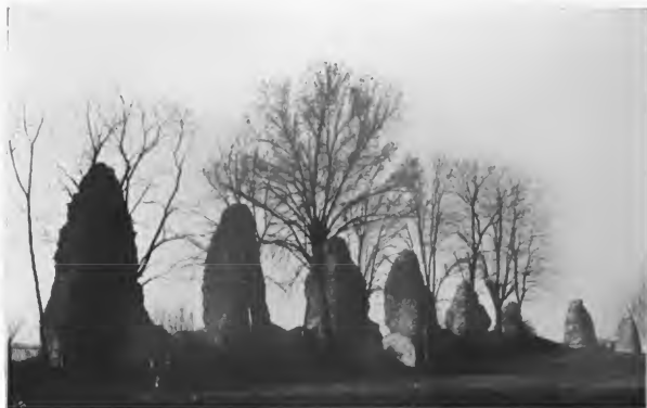
Abb. 38. Pfeiler der römischen Wasserleitung bei Mainz.
