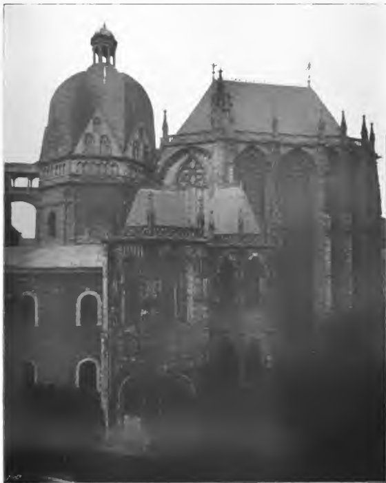
Abb. 134. Der Dom zu Aachen. Unter Karl ist nur der links besitzliche Rundbau errichtet, das übrige jüngere Götik von 1417. Das Dach des Rundbaues ist im 18. Jahrhundert aufgesetzt.
