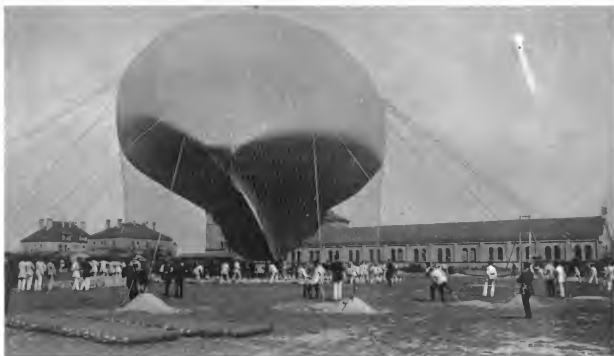
1. Füllung des Ballons «Preussen» (8400 cbm) mit Wasserstoff.
