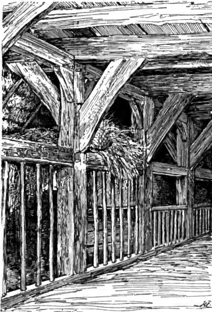
138. Bahlum, Dälenkonstruktion des Hauses Nr. 15.
