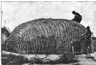
Bau einer Kaffernhütte.
