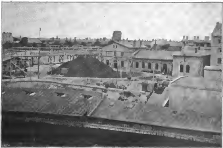
Fig. 4. Blick in den Kohlenhof der Älteren Anlage nebst Pack- und Verladeschuppen der Portland-Zementfabrik Rüdersdorf.
