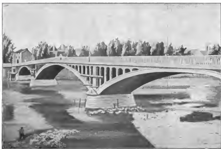
Fig. 16. Brücke von Clätellerault über die Vienne.
