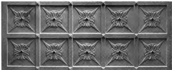
TEIL EINER STUCKDECKE
