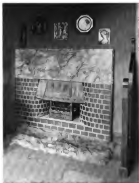
KAMIN AUS DEM WOHNZIMMER: RÖTLICHER MARMOR U. ROTE VERBLENDSTEINE; RAUCHHELM V. KUPFERBLECH
