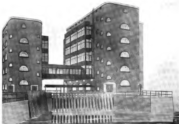
HANS POELZIG-BRESLAU ■ ENTWÜRFE FÜR DIE WERDERMÖHLE IN BRESLAU UND FÜR EINEN WASSERTURM
