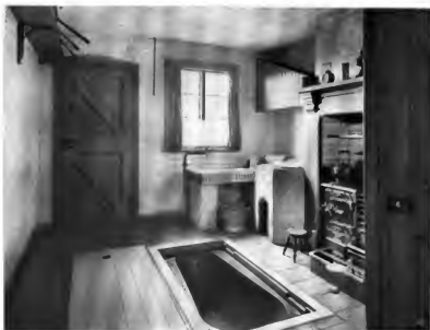
KÜCHE MIT VERSENKTEM BAD IN EINEM ARBEITER-WOHNSHAUS
