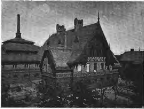
Abb. 753. Kunheim'sche Fabrik „Kanne“, Beamtenswohnhaus und Stallung.
