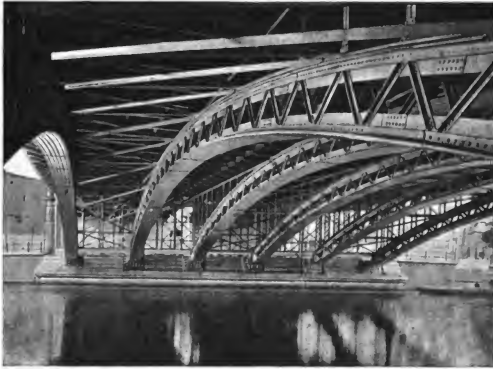
Abb. 277. Spreebrücke am Schiffbauerdamm, Unteransicht.
