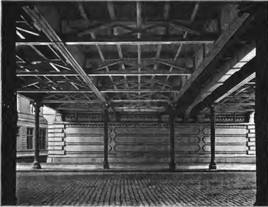
Abb. 285. Unterführung an der Spandauer Brücke, Unteransicht.
