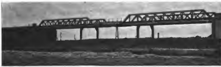
Abb. 326. Eisenbahnüberführung bei Westend.
