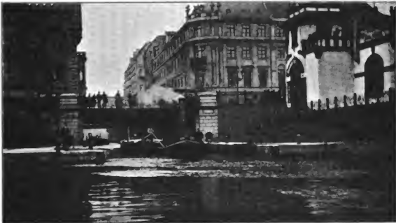
Abb. 91. Oberhaupt der Mühlendammschleuse.
