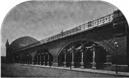
Abb. 309. Viaduct am Bahnhof Friedrichstraße.
