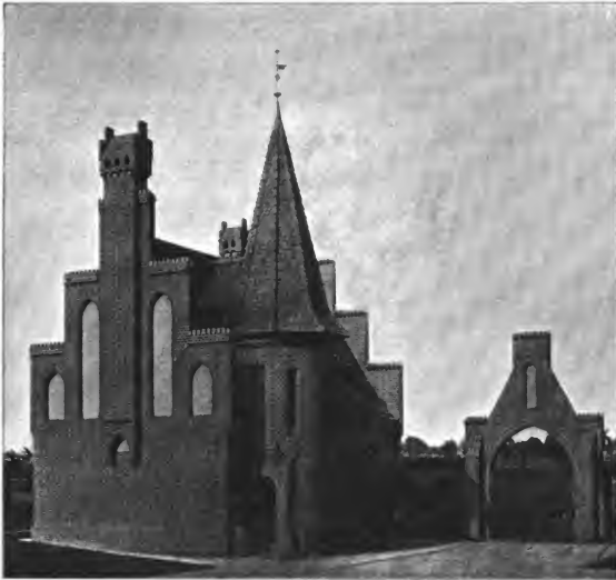
Abb. 413. Pfortnerhaus des Wasserwerks Lichtenberg.
