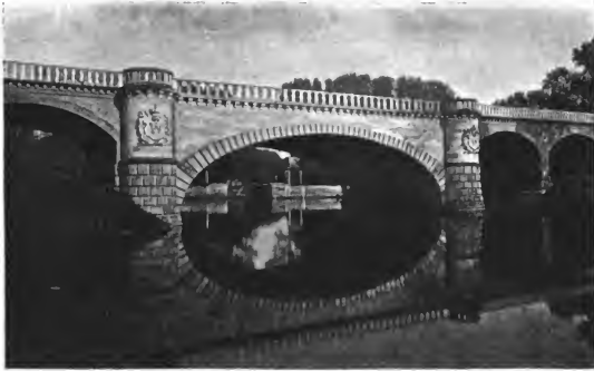
Abb. 269. Brücke über den Landwehrkanal.
