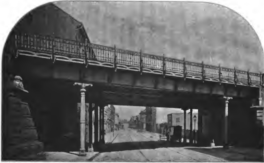
Abb. 283. Unterführung der Karlstraße.
