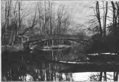
Abb. 214. Eiserne Bogenbrücke am Neuen See.
