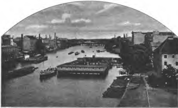
Abb. 61. Oberspree mit der v. Pfuel'schen Badeanstalt (vor dem Neubau der Oberbaumbrücke).
