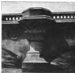
Abb. 130. Pfeilerkopf der Waisenbrücke.
