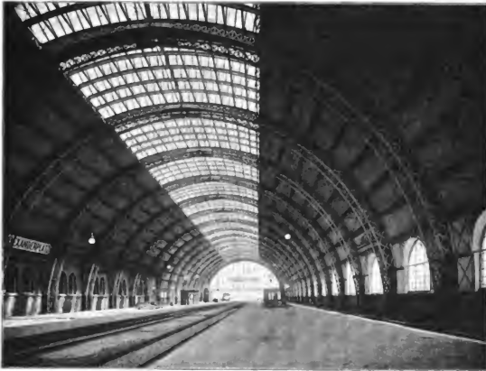
Abb. 297. Bahnhof Alexanderplatz, Innenansicht.
