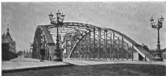
Abb. 341. Kurfürstendammbrücke in Halensee.
