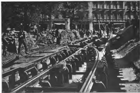
Abb. 258. Elektr. Straßenbahn mit unterird. Stromzuleitung am Dönhofsplatz. (Gr. Berl. Pferdeisenbahn.)
