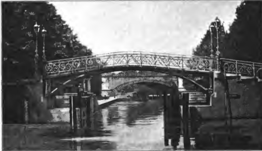
Abb. 215. Fußgängerbrücke an der Unterschleuse des Landwehrcanales.
