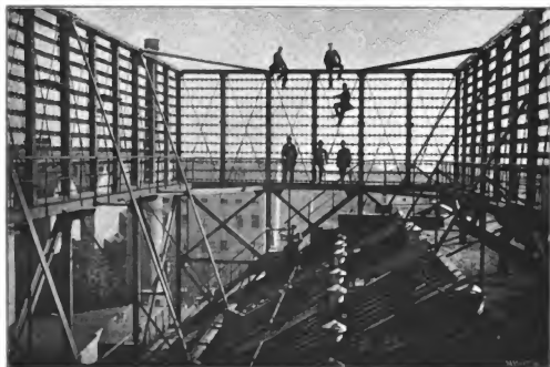
Abb. 553. Abspanngerüst einer Fernsprechanlage.
