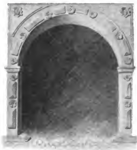
Fig. 58. Bechin. Granitportal vor der Durchfahrt in das alte Schloss.
