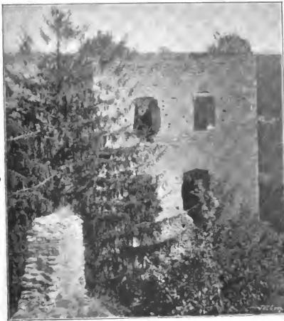
Fig. 91. Kokofin. Der ehemalige Burgpalast
