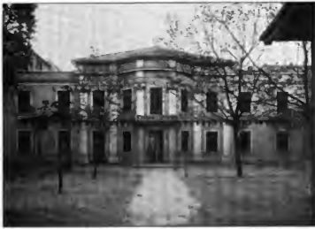
Das Stephanienschloßchen mit den späteren Stügelanbauten nach einer Photographie vom Jahre 1904.
