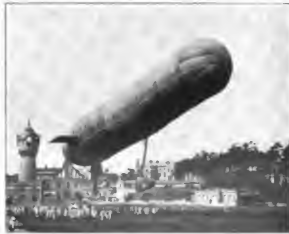
Abb. 1. — Abfahrt vom Platz des Luftschifferbataillons.
