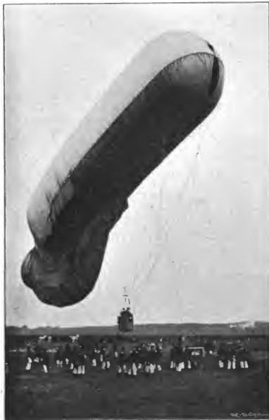
Der Aufstieg des Fessel-Drachensballons beginnt, nachdem das Haltkabel am Windwagen befestigt ist.
