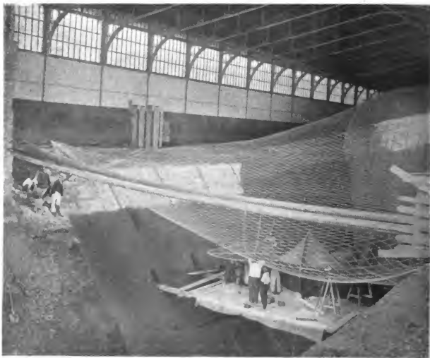
Gonflement du ballon à Toul. (Le filet est tendu d'avance.)
