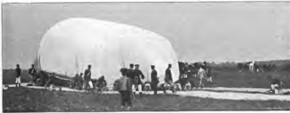
Die Gasentleerung des Ballons nach Öffnen der Entleerungsöffnung durch Niederdrücken durch Mannschaften.
