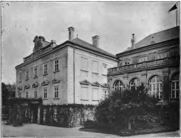
Fig. 55. Schloss. Hlubosch. Nordwestliche Fronte.
