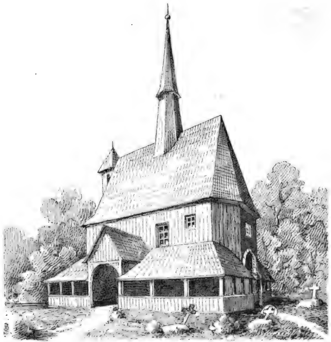
Fig. 1. Ansicht der Holzkirche zu Braunau.
