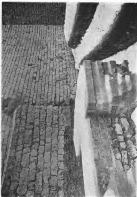
Textabbildung 5: Südlicher Teil der Halbkreismauer (W2 und W4). Links: Mauer W2, daran angeschlossen: Mauer W4. Rechts ein Stöck der Mauer S1 (Tafel D). Im Vordergrund: Mauern der Perioden I und II.
