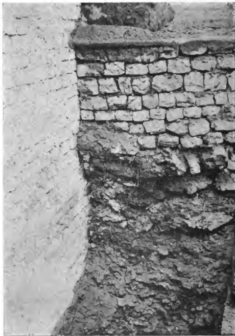
Textabbildung 6: Treppentrittfundament K der Periode III e, angebaut an die bedeutend tiefer reichende Caveabschlussmauer der Periode III d (S. Tafel I)
