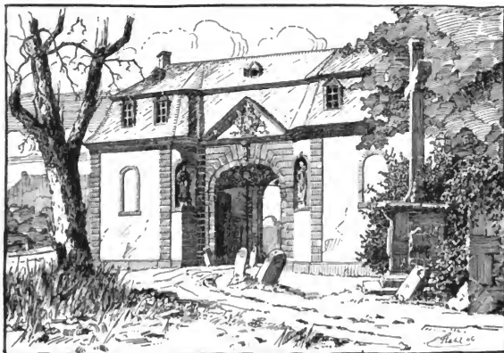
Fig. 44. Heisterbach. Ansicht des Torgebäudes.
