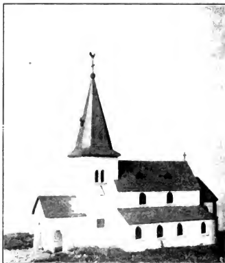
Fig 266. Witterschlick. Die ehemalige kath. Pfarrkirche.
