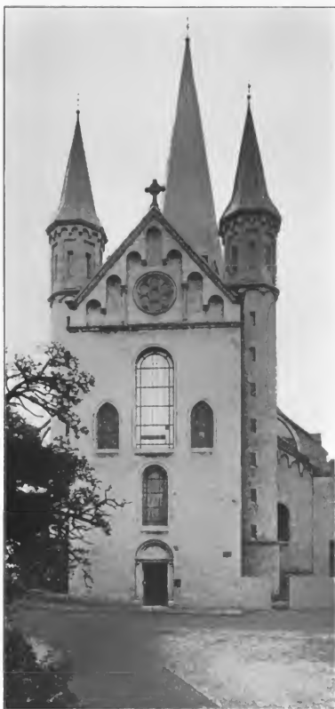
Fig. 18. Bonn. Der Westchor des Münsters nach der Wiederherstellung.
