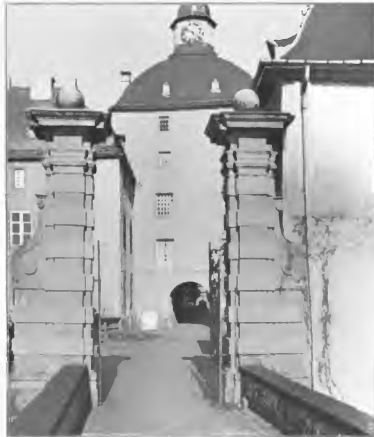
Fig. 205. Gudenuau. Brückenpfeiler am Eingang zum Garten.
