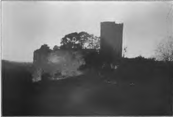
Fig 11. Blankenberg. Ansicht des Hochschlosses.
