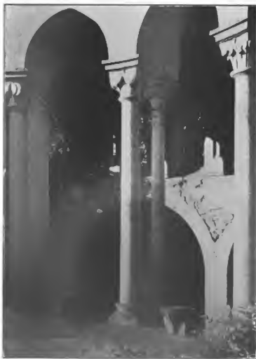
Fig. 38. Heisterbach, Chorrinne. Säulenstellung des Umganges.
