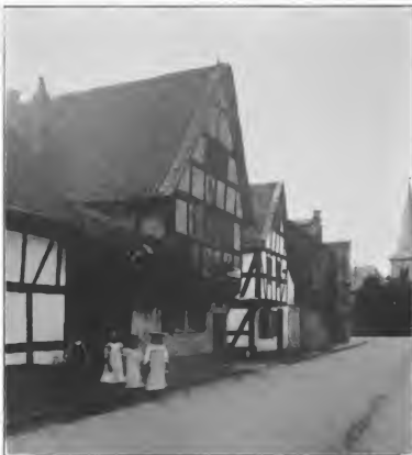
Fig. 93. Niederdollendorf. Fachwerkhaus vom Ende des 16. Jhs.
