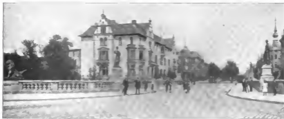
Die neue Kaiser Wilhelm-Brücke in Braunschweig.
