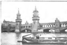
Die mittleren Pfeiler der Oberbaumbrücke.
