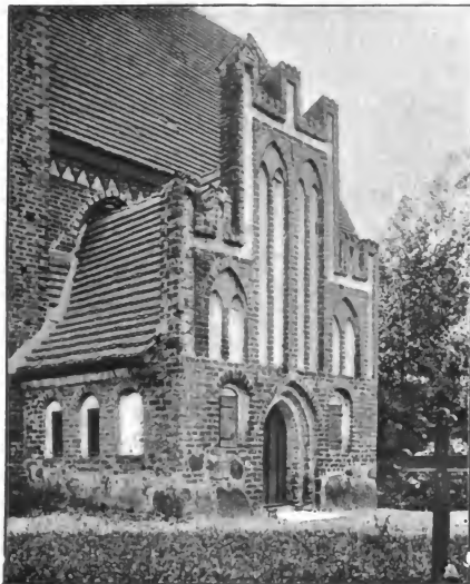
Vorhalle auf der Südseite der Kirche.
