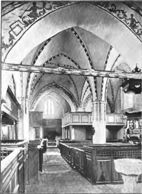
Blick aus dem Chor ins Schiff. Vor der Restauration von 1898/99.
