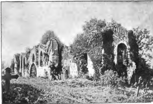
Ruine der alten Kirche zu Satow.
