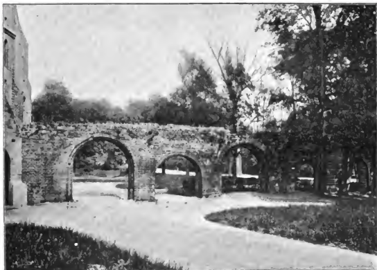
Romanischer Bogengang, Westseite.
