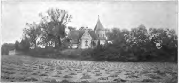
Kirche zu Westenbrügge von der Nordseite.
