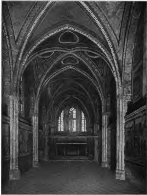
Abb. 67. Innenansicht der Oberkirche von San Francesco zu Assisi.
