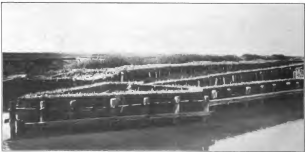
Fig. 8. — Ottela mit Wänden aus fünfmaliger Rohrschicht.
