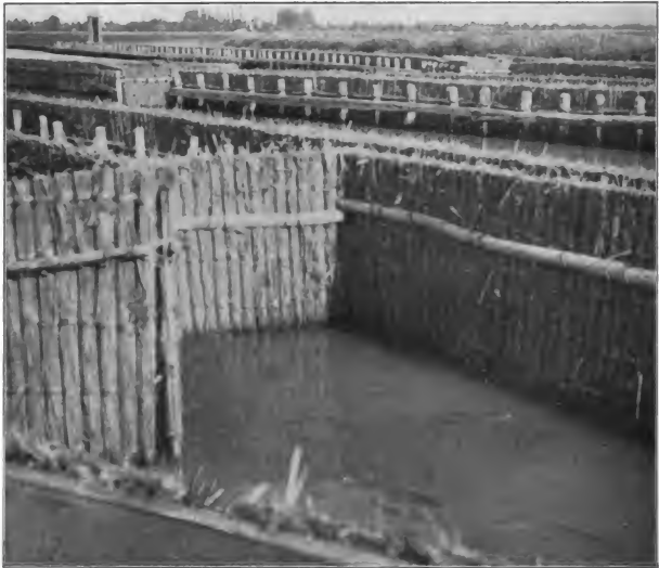
Fig. 6. — Rohrverkleidung des Ufers am Anfang eines Fanglabyrinthes.
