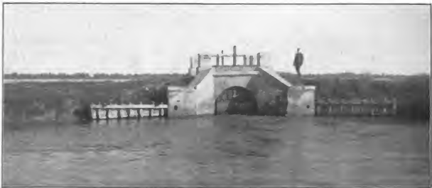
Fig. 3. — Schleuse, durch die Seewasser zum Valle tritt.
