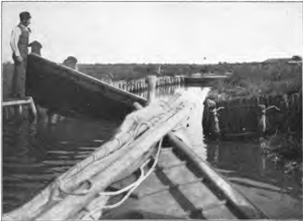
Fig. 2. — Schleue, vorn geöffnet, hinten geschlossen, zur Einfahrt in ein Valle.
