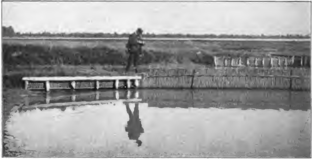
Fig. 6. — Rohrverkleidung des Ufers am Anfang eines Fanglabyrinthes.
