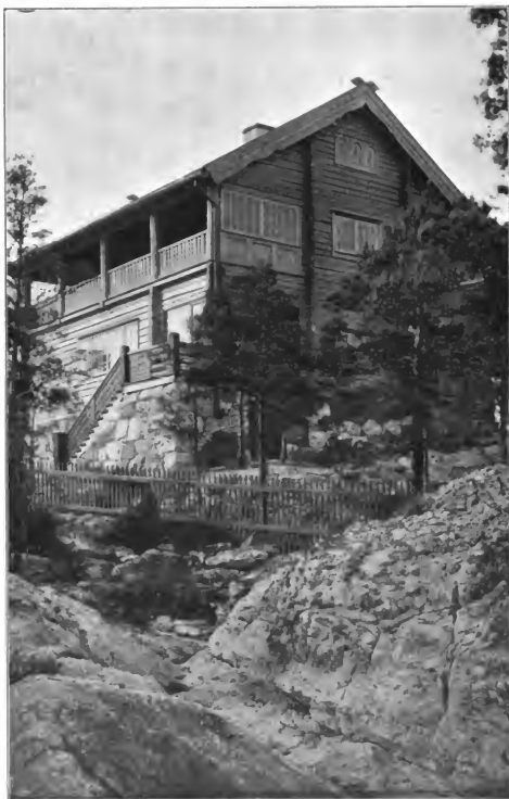
Fig. 133. Eva Bonniers Wohnhaus auf Dalarö. Gezimmertes Gebäude.
