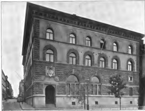
Fig. 50. Gebäude der Sparbank an der Fredsgata in Stockholm. Material: Granit; die oberen Stockwerke mit verputzten Mauerflächen.
