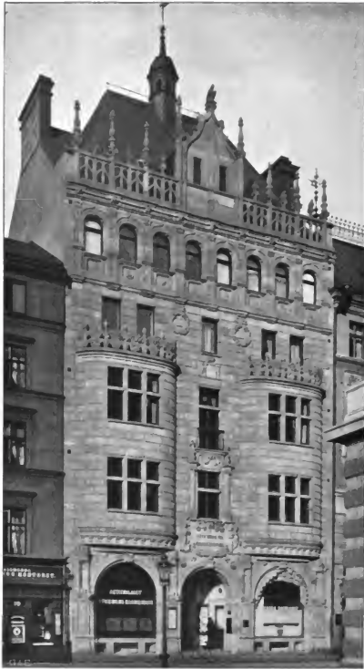
Fig. 74. Das Gebäude No 8 Arsenalsgatan, Stockholm. Aufgeführt in rotem fein belauenen Sandstein.
