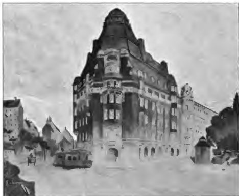
Fig. 59. Haus der Gesellschaft Trygg in Stockholm. Die Fassaden in Granit und Hand-geschlagenen Ziegeln mit Dachdeckung von glasierten schwarzen Ziegeln.
