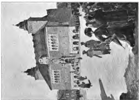
Fig. 94. Das Rathaus in Borås. Fassadenmaterial: roter, Hand-geschlagener Ziegelstein und Granit. Das Dach mit glasierten, braunen Dachziegeln belegt.
