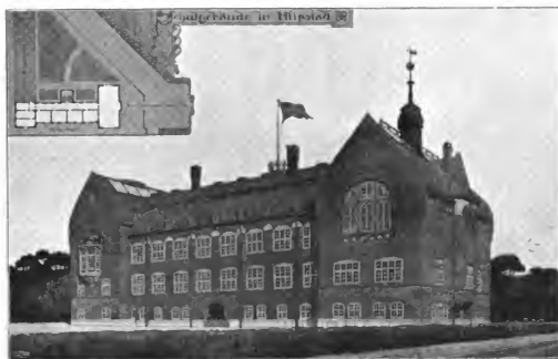
Fig. 128. Schulgebäude in Filipstad.
