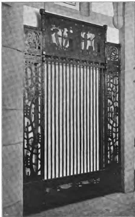
Fig. 112. Gebäude der Ärztlichen Gesellschaft in Stockholm. Gitterthür am Haupteingang in gehämmertem Schmiedeeisen.
