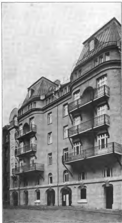
Fig. 44. Häuserkomplex in Stockholm. Material für die Fassade: Granit und gelbgrauer, grober Verputz.
