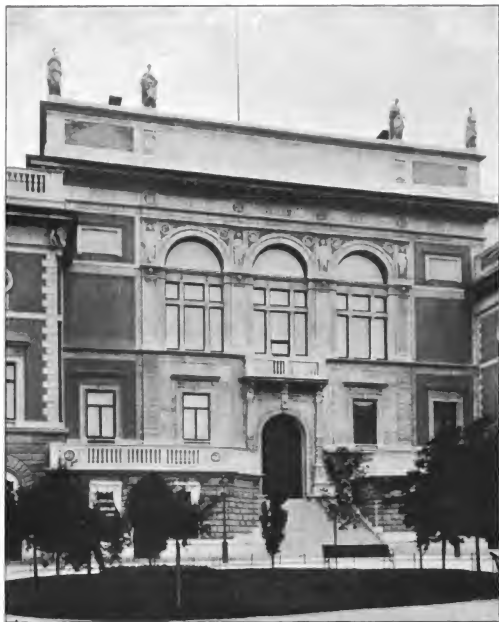
Fig. 57. Die Kunstakademie in Stockholm. Die Fassaden in gehauenen Kalkstein mit verputzten Aussenflächen.
