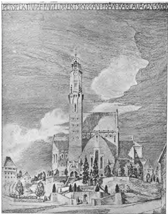
Fig. 98. Die Engelbrekts-Kirche in Stockholm. Die Fassaden in rotem, Hand-geschlagenem Ziegelstein mit sparsamer Anwendung von rotem Sandstein. Die Bedachung besteht aus glasierten, braunen und grün-braunen Ziegeln mit der Turmkrone in Kupfer und Spitzen von vergoldetem Schmiedeeisen,
