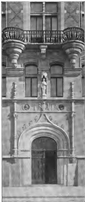
Fig. 27. Partie des Bünsow'schen Hauses, Strandvågen, Stockholm. Material: Ziegelstein und Kalkstein.
