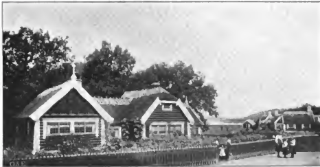
Fig. 106. Arbeiterwohnung bei Tjolöholm. Holzgebäude mit Brettverschalung, rot getüncht mit weissen Säumen. Gedeckt mit Strohdach.
