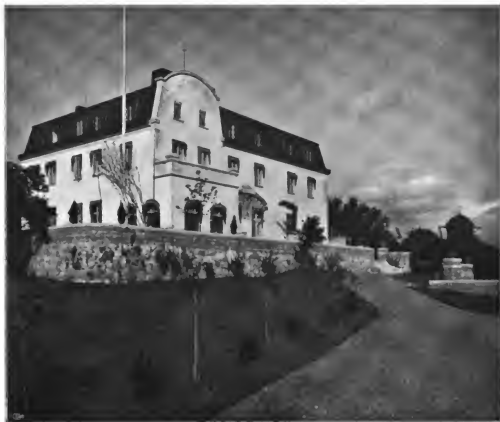
Fig. 20. Die Villa S. K. H. des Prinzen Eugen im Tiergarten, Stockholm. Die Fassaden in weissem Verputz mit rötlichem Sandstein. Die Dachdeckung besteht aus grünen Ziegeln.
