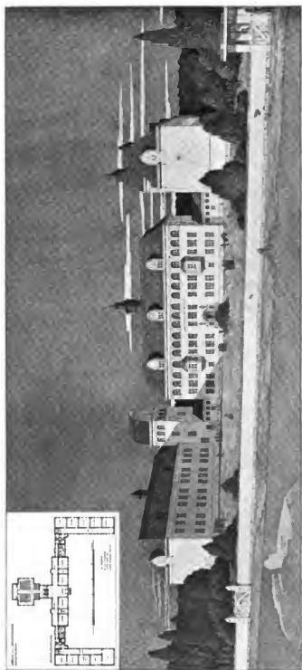
Fig. 81. Schulgebäude in Djursholm. Weiss verputzte Fassaden mit Kachelnmalagen. Bedachung in roten Ziegeln.
