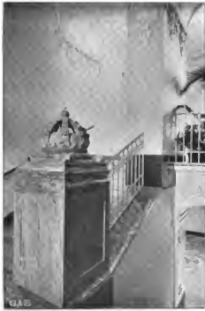
Fig. 85. Das Uppsala-Schloss. Restauration. Der Treppenaufgang.
