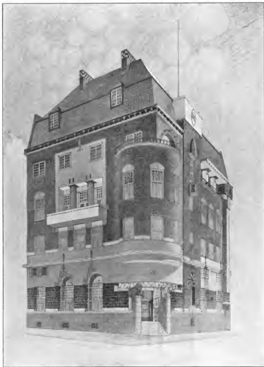
Fig. 5. Bankgebäude in Norrköping. Die Fassaden in rotem Ziegelstein und gehauenen Stein. Die Dachdeckung in Ziegeln.
