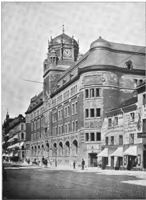
Fig. 14. Das Postgebäude in Stockholm. Material roter Sandstein und Handgeschlagene Ziegel.
