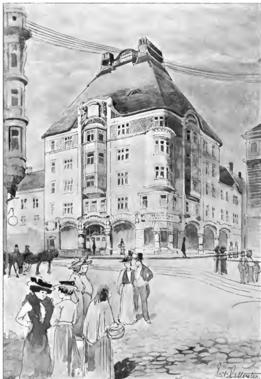
Fig. 54. Das Westerås—Bergslagen-Gebäude in Stockholm. Die Fassaden in fein behauenen Kalkstein und hell verputzten Oberflächen. Dachdeckung in Schiefer.
