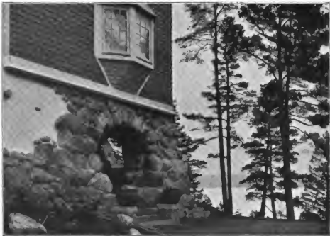
Fig. 117. Detailpartie eines Holzgebäudes bei Saltsjöbaden. Der Sockel von Rollsteinblöcken in Granit.
