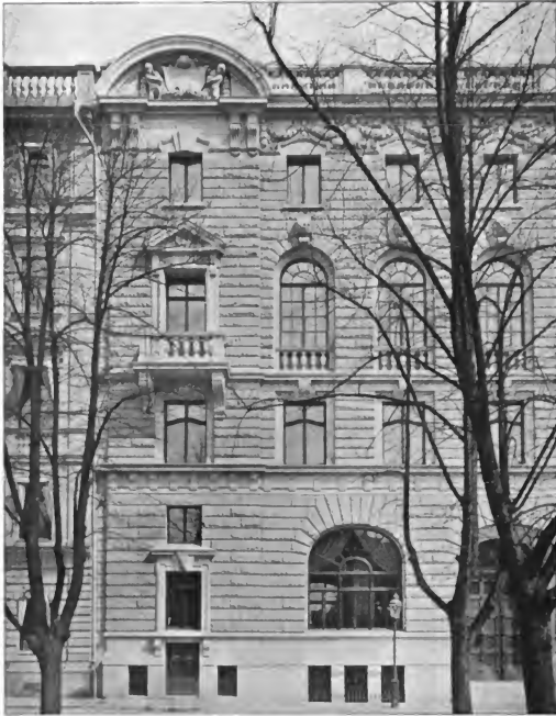
Fig. 52. Fassade des Gebäudes der Handelsbank in Stockholm. Fassadenmaterial: roh behauener und fein behauener gelbgrauer Granit.
