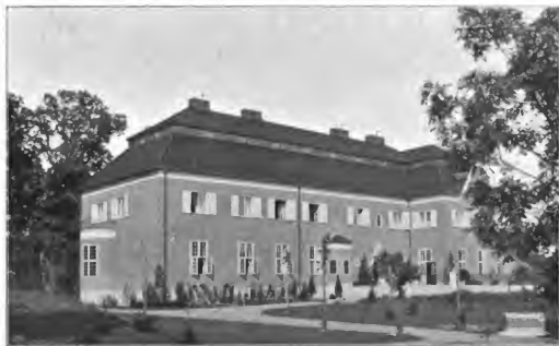
Fig. 138, 139. Albert Pauli's Wohnhaus, Djursholm. Material für die Fassaden: roter Ziegelstein und Granit. Bedachung in grünbraunen Ziegeln.
