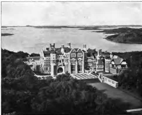
Fig. 102. Das Tjoleholmer Schloss. Die Fassaden durchweg von roh behauenen und fein behauenen rotem Granit. Das Dach ganz mit Kupfer gedeckt.
