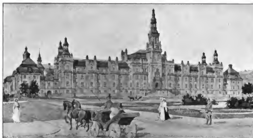
Fig. 77. Polizei-gebäude auf Kungsholmen in Stockholm.
