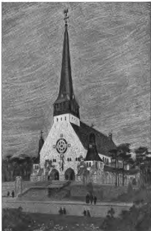
Fig. 92. Kirche in Arvika. Material: roh behauener Granit und weiss verputzte Mauerflächen. Bedachung von Schiefer. Inwendig: Kalkmalereien auf weissem Grunde und offene Dachkonstruktion in Holz.
