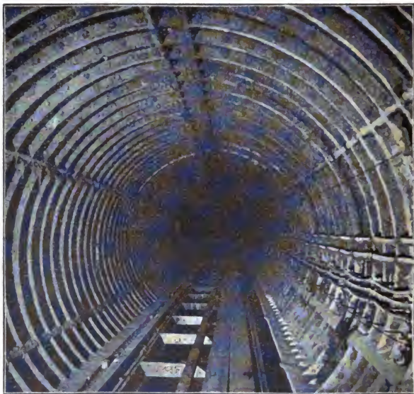
Fertiger Tunnel der Zentralbahn.
