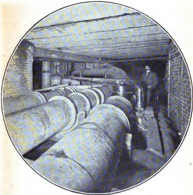
Unterirdischer Gang für die Wasserleitungs-Abzugs- und Gasröhren.
