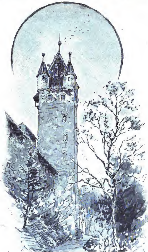
An der Stadtmauer.
