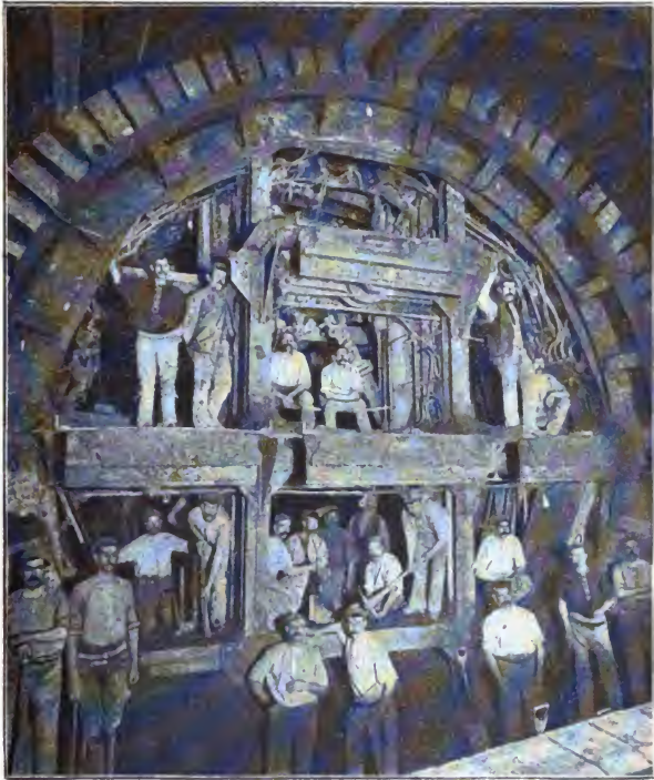
„Schild“ für die Tunnelbohrung.
