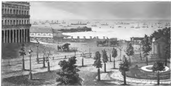
Hafen von Buenos Aires. (Nach einer Photographie.)
