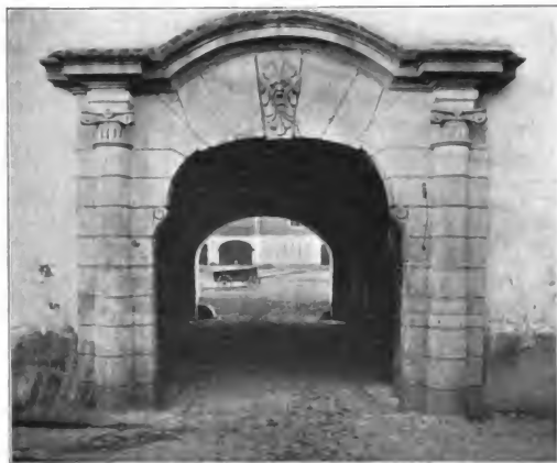
Obr. 47. Jenč. Dvůr. Portál v průčelí.
