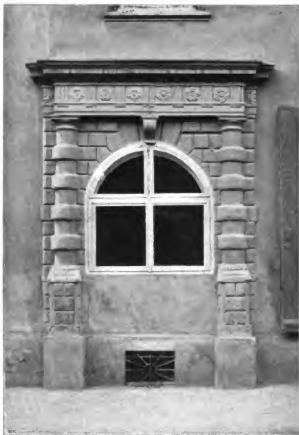
Obr. 113. Unhošť. Portál na d-umě čís. 4
