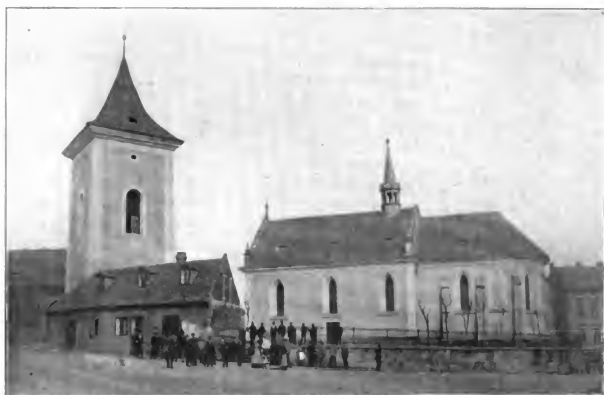
Obr. 51. Kladno. Kostel P. Marie. Pohled od jihovýchodu. (Stav před zbořením r. 1897.)
