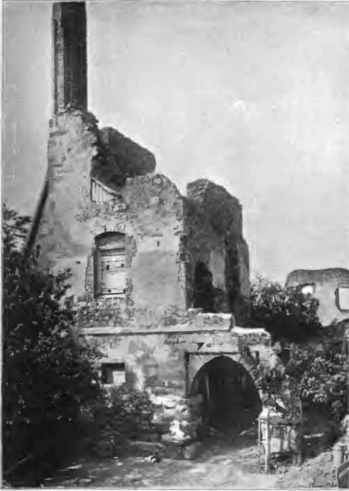
Obr. 61. Roupov. Vnitřní brana hradní.
