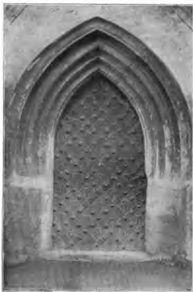
Obr. 54. Kladno, Kostel P. Marie. Portál na západní straně.
