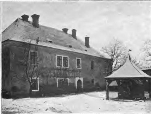
Obr. 102. Toskánka. Pohled do nádvoří.
