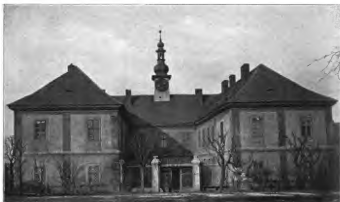
Obr. 63. Kladno. Zámek. Pohled od jihu.
