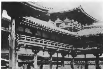
Nr. 32. Seitenflügel vom Phönixtempel Kioto. Rot lackiertes Holzdach aus Ziegeln; 1051.
