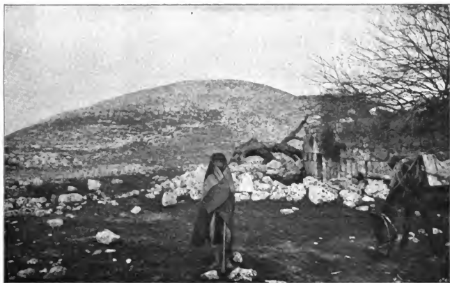
55 Ruinen von Silo
