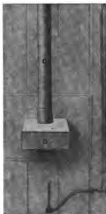
Fig. 12. — Abzug außerhalb des Arbeitsraums.
