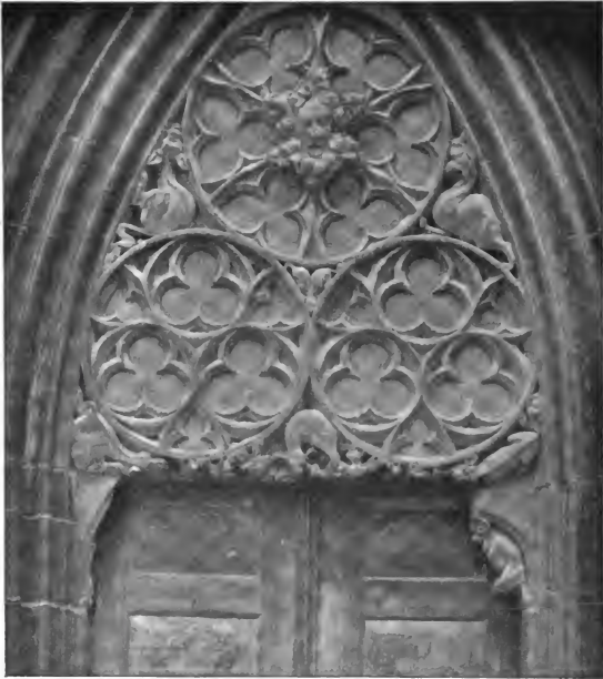
Neutlingen. Marienkirche. Nordwestliches Portal.
