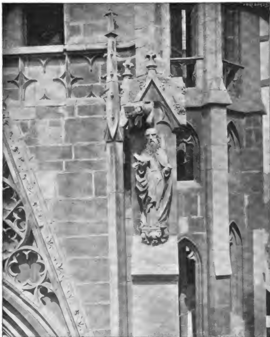
Neutlingen. Marienkirche. Südwestecke.
