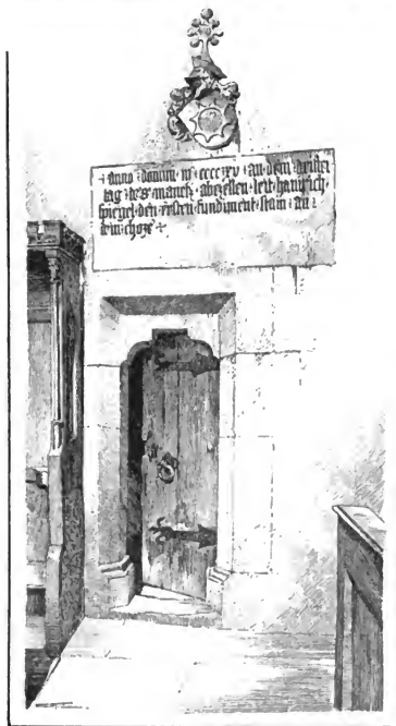
Bronnweiler. Chorgekühl und Thüre des Treppen-Türmchens.
